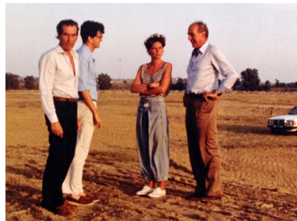
A SINISTRA Primi lavori per il campo da golf, 1987
